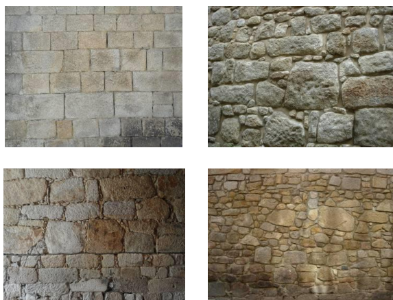
Fig. 2 – Diferentes texturas de paredes de alvenaria de pedra.
